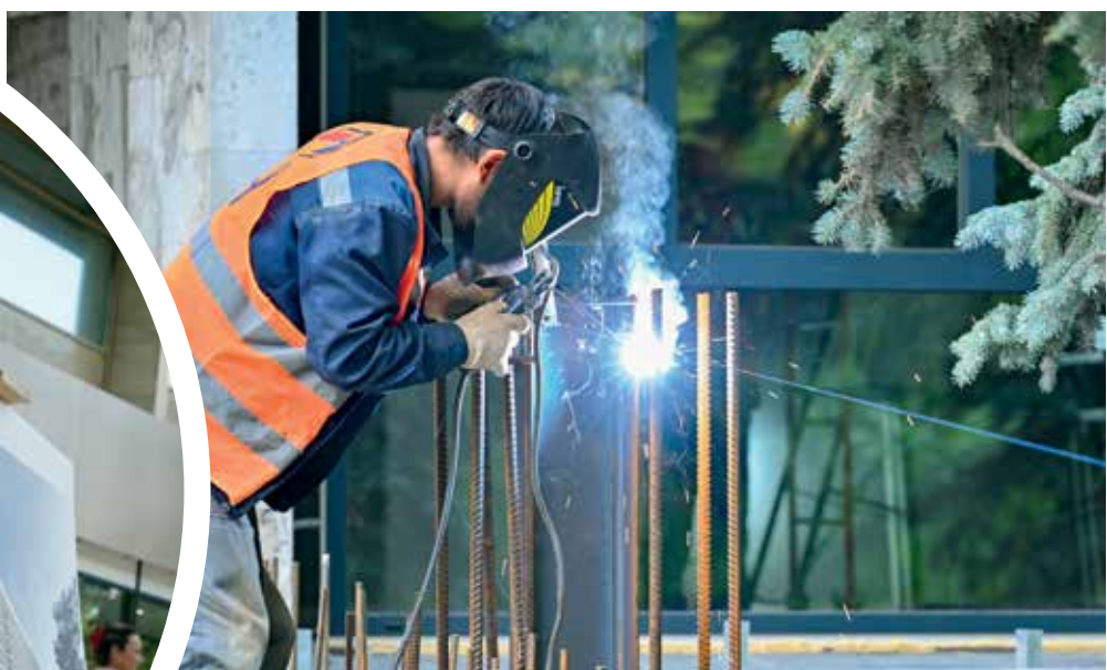
▲ Строитель варит конструкцию специального парапета для машин скорой помощи ▲ Так будет выглядеть новый главный корпус больницы
