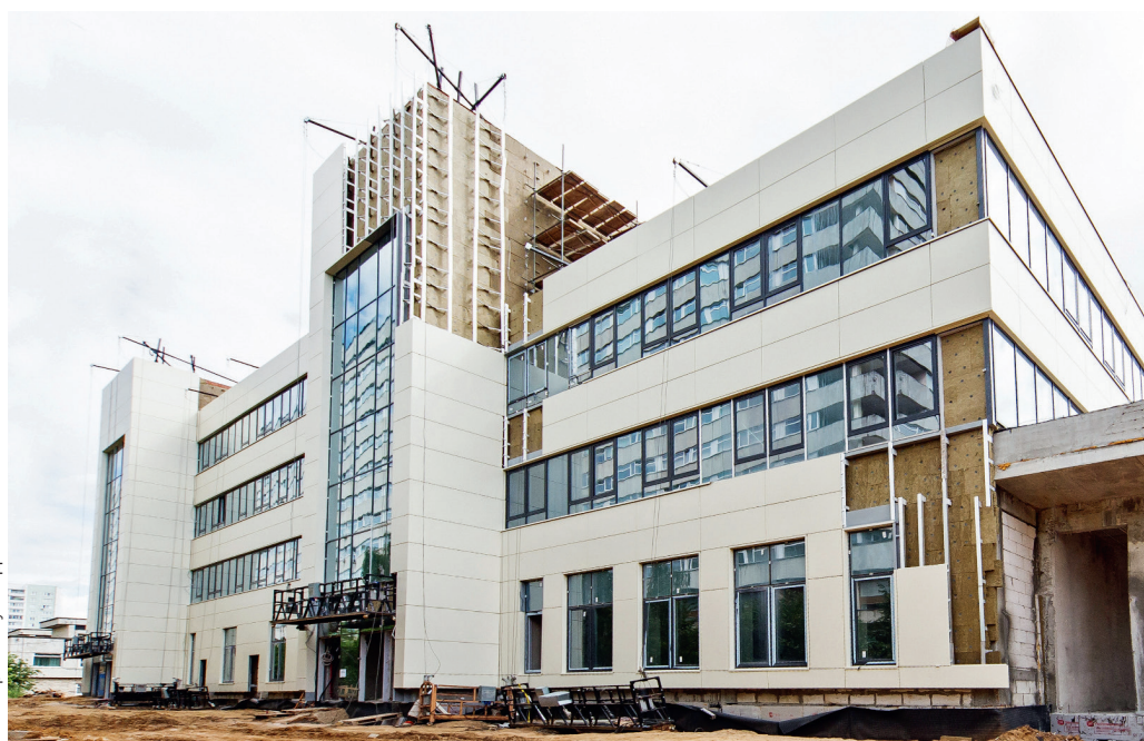
▲ Пока что скорпомощной комплекс на стадии строительства
